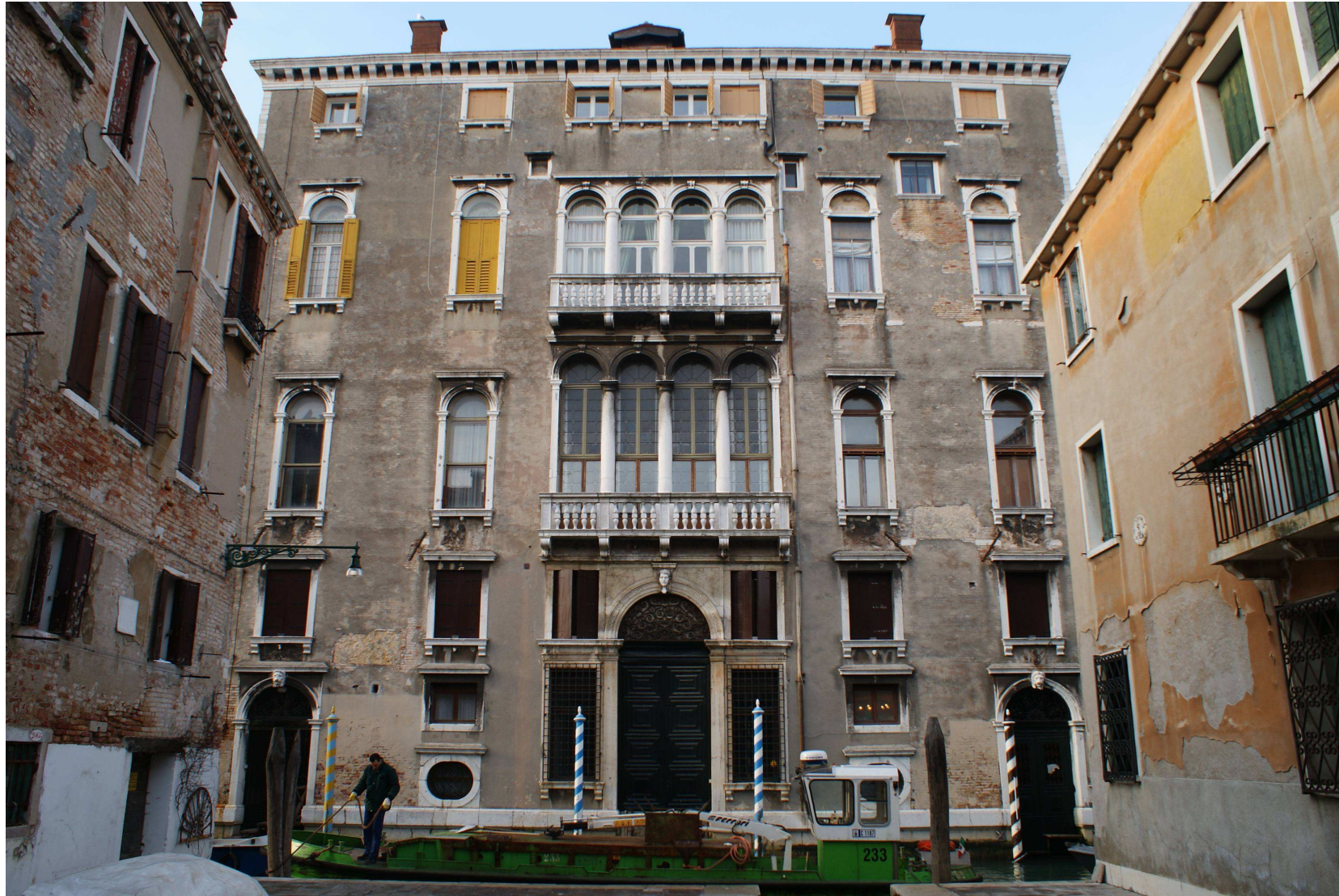
3. Palazzo Barbarigo della Terrazza vom Rio di San Polo aus gesehen Palazzo Barbarigo della Terrazza visto dal Rio di San Polo
